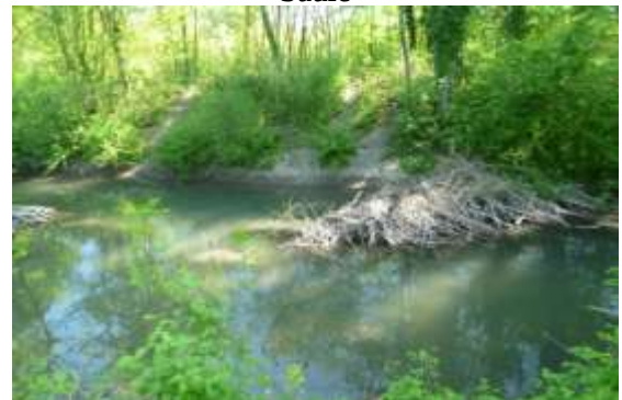
Barrage démoli – Rive droite
