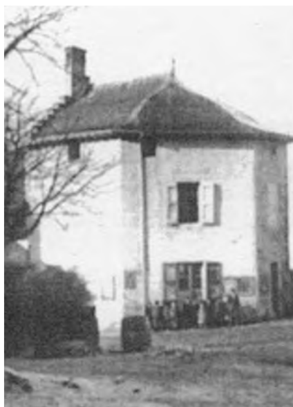
Bâtiment Gouvert école de garçons de 1860 à 1892
