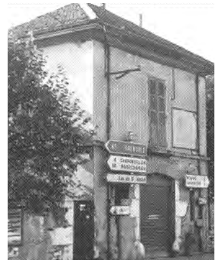
Bâtiment construit en 1867 contenant au rez-de-chaussée la pompe à incendie et à l'étage la salle de mairie de 1867 à 1892
